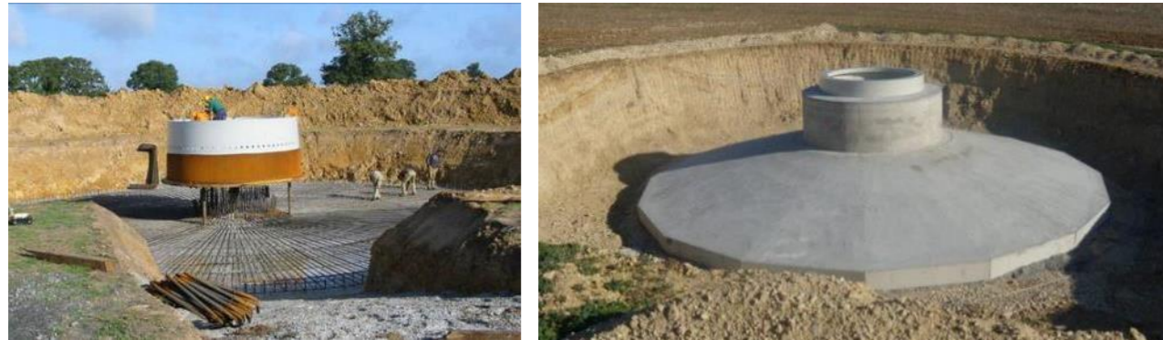
Figure 13 : Le ferrailage et le coulage d'une fondation d'éolienne
